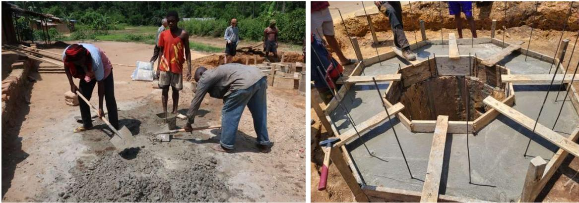
Während gemischt und betoniert wird, bereiten wir die Schalung für das Mannloch vor. Mit Laser und Schaufeln bewaffnet, kurven die drei Stahlesel dann nach Makanga-Nsundi, wo die zweite Pumpe installiert werden soll, und egalisieren die Fläche um das Brunnenloch herum.
